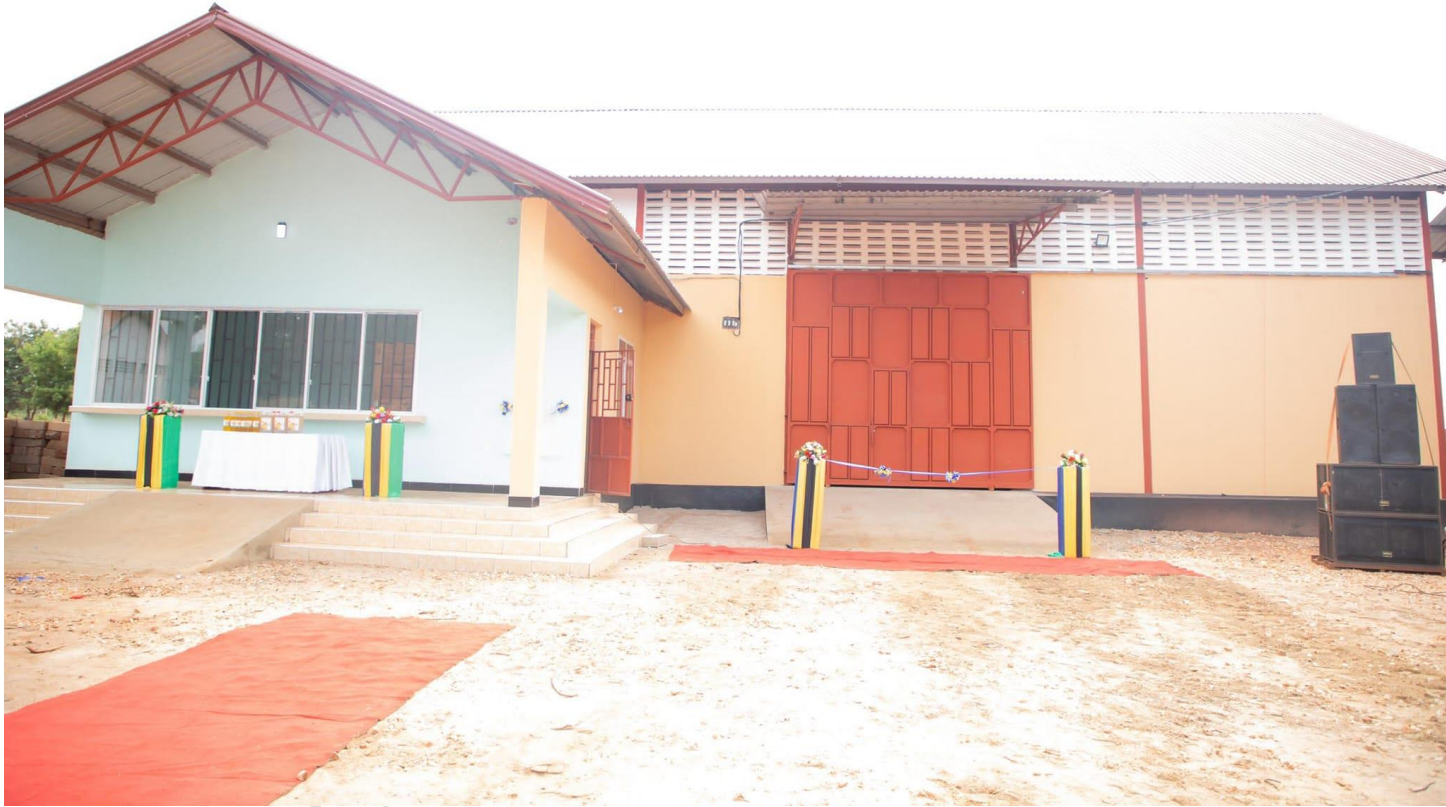
Kiwanda cha kuzalisha mafuta kinachomilikiwa na Chama Kikuu cha Runali
